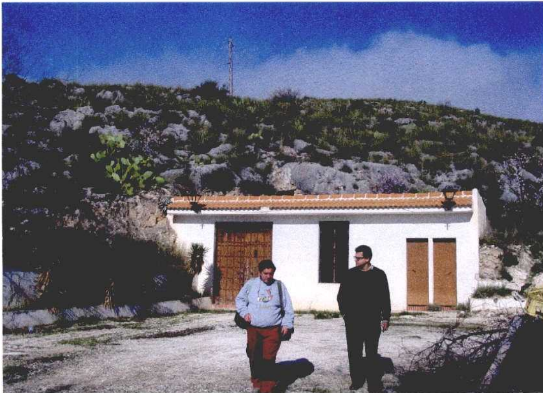
Edificio de entrada a la cavidad (Foto 2)
