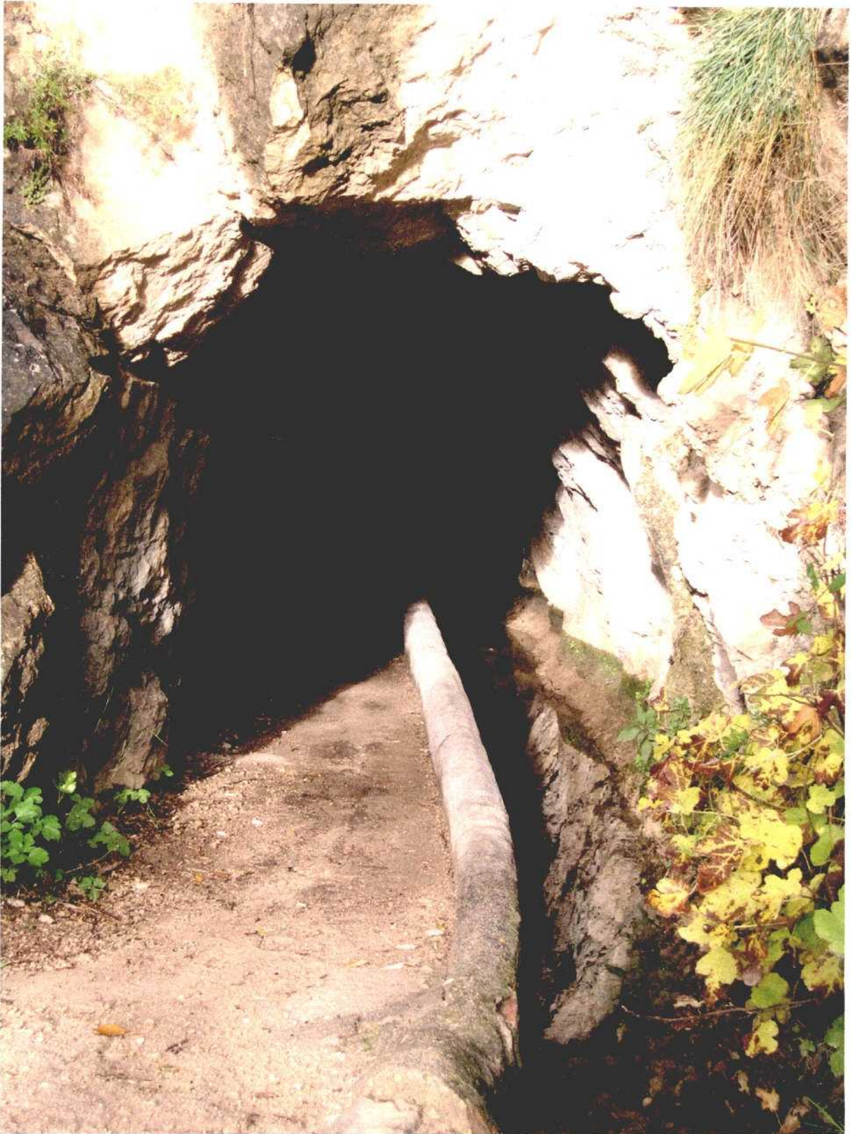
Túnel de acceso (Foto 2)
