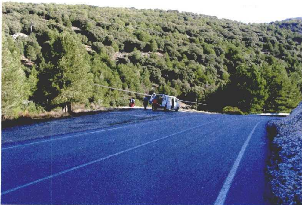
Segunda zona de aparcamiento (Foto 3)
